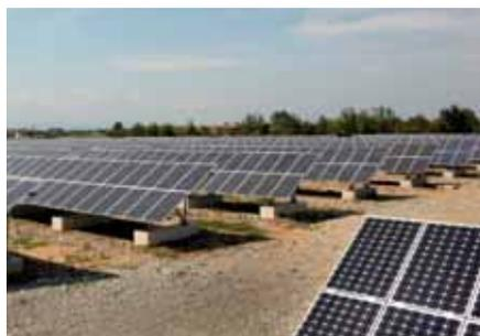
to realizzato da Renegies Italia per Unendo Energia. L'impianto, a impatto zero, si estende su una superficie di 20 mila metri quadri ed è costituito da 5.808 pannelli fotovoltaici in silicio monocristallino in grado di produrre, nelle condizioni di irraggiamento più favorevoli, circa 1.200 Megawattora all'anno. L'investimento, di 2 milioni e 500 mila euro, sarà ammortizzato in 8 anni circa.
