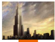
nel quartier generale del gruppo, trasportati sul luogo della costruzione, messi in posizione e assemblati come una sorta di gigantesca costruzione di Lego. *Sky City* sarà alto 838 metri con 202 piani, 92 ascensori, 10 chilometri di scale e un totale di oltre 1 milione di m² e potrà ospitare 30.000 persone, tra appartamenti, uffici, alberghi, scuole e ospedali.
