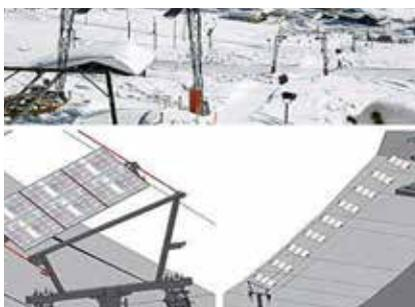
ed è munito di 82 *ali solari*, ovvero installazioni pesanti ognuna oltre un quintale, munite di tre pannelli solari. I pannelli sono stati realizzati in modo da posizionarsi verticalmente in caso di forti nevicate, evitando così pericolosi accumuli sulla struttura.
