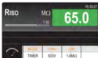
Misura di resistenza di isolamento
